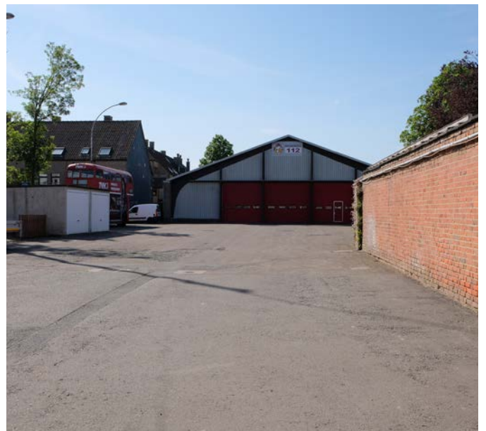
De erg verharde site van de brandweer
